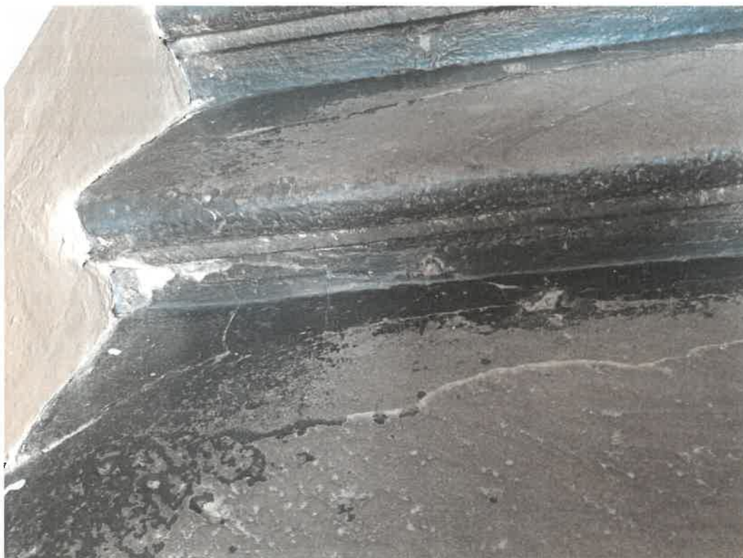
Fot. 5. Spękania kamienia, kitów i pozostałości farby. Widoczny stan powierzchni w partii cokołu.
