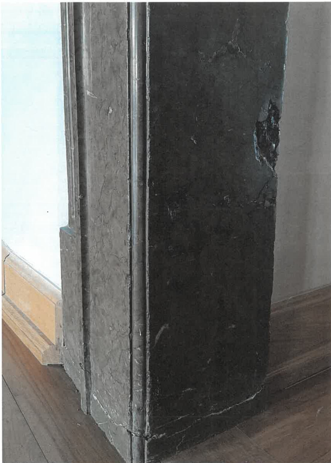
Fot. 11. Fragment portalu marmurowego pomiędzy Sienią Wielką a Salą Portretową. Widoczne ubytki kamienia oraz spękania w dolnej partii wynikające z niewłaściwego posadowienia elementu.
