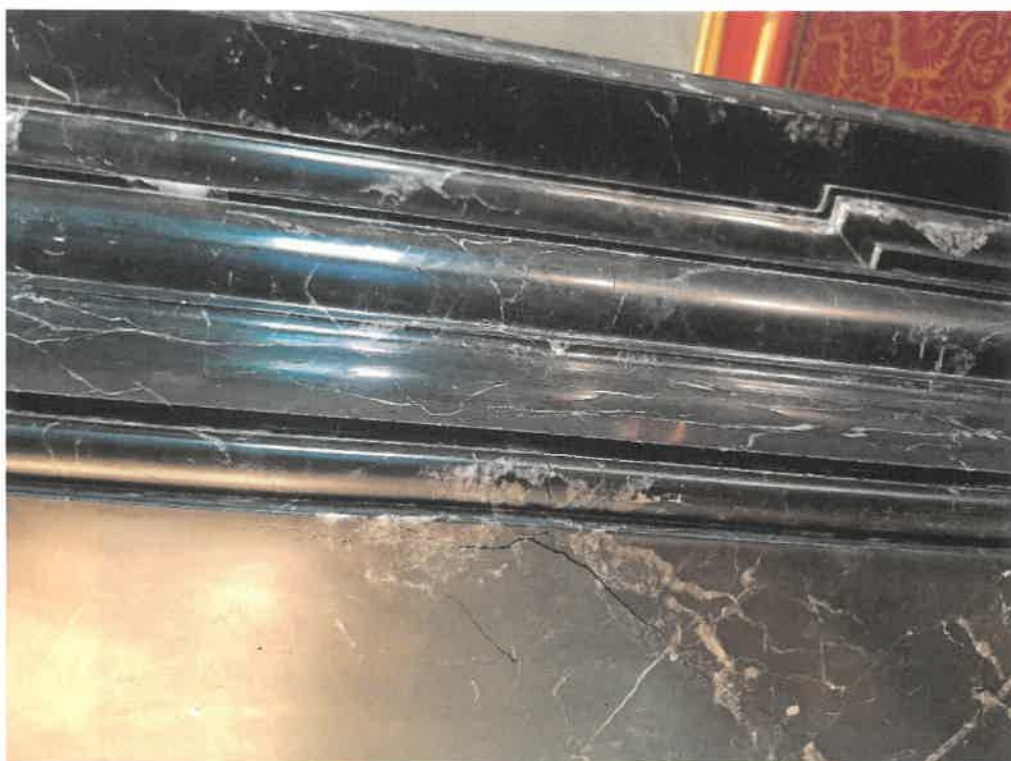
Fot. 9. Spękania powierzchniowe kamienia portalu w II Pokoju Biskupim.
