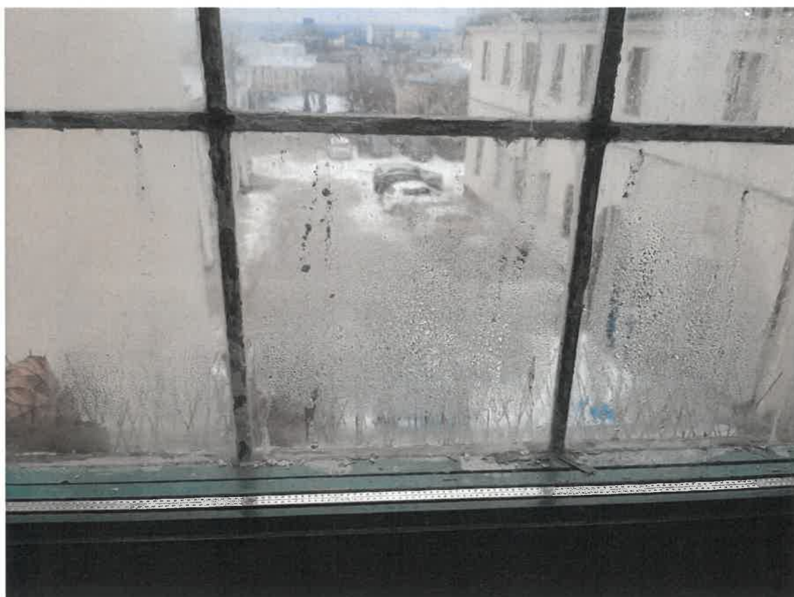
Fot. 5. Korozja ołowiu spajającego szkła witrażowe, skraplanie wody wewnątrz skrzydeł okiennych na przykładzie jednego z okien północnych.
