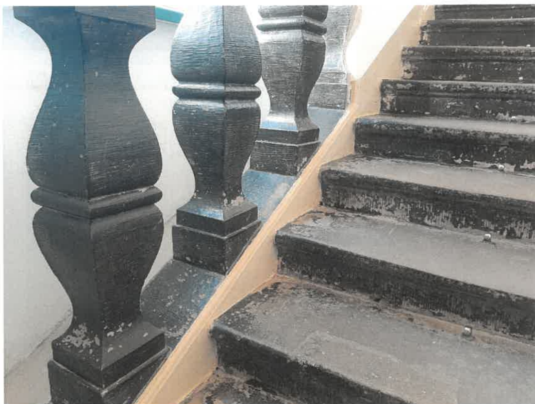
Fot. 3. Fragment balustrady. Stan przed konserwacją.
