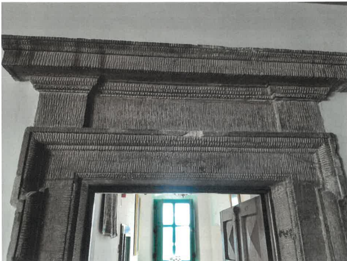
Fot. 7. Stan zachowania portalu z piaskowca na przykładzie portalu przy wejściu z Sienie Wielkiej do Skarbczyka.
