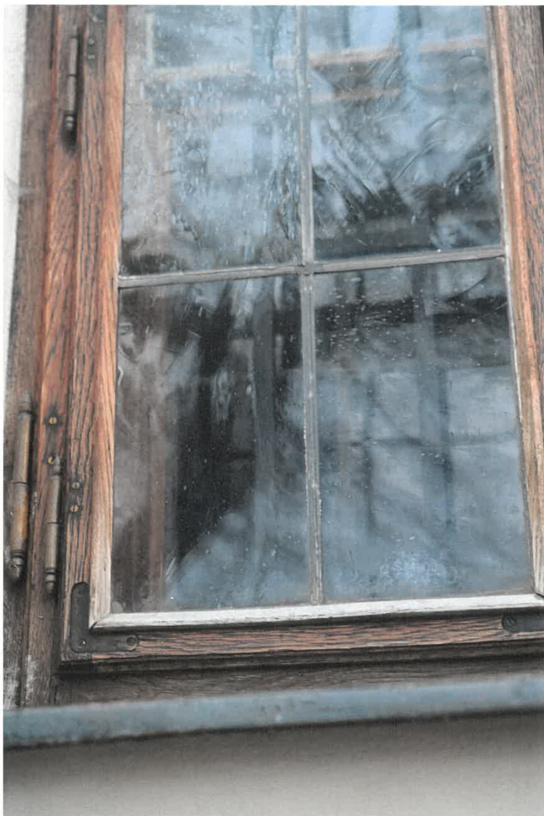
Fot. 3. Stan zachowania drewna na przykładowym oknie elewacji południowej. Widoczne złuszczenie lakieru na poziomym elemencie obramienia.
